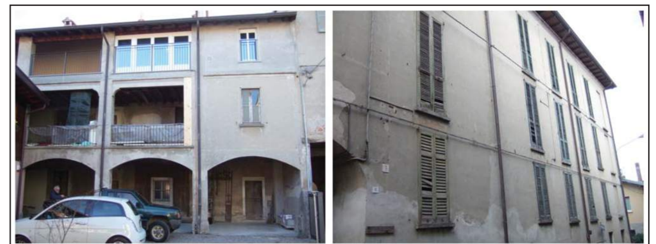
Immagine 1 e 2 - edificio dall'esterno
