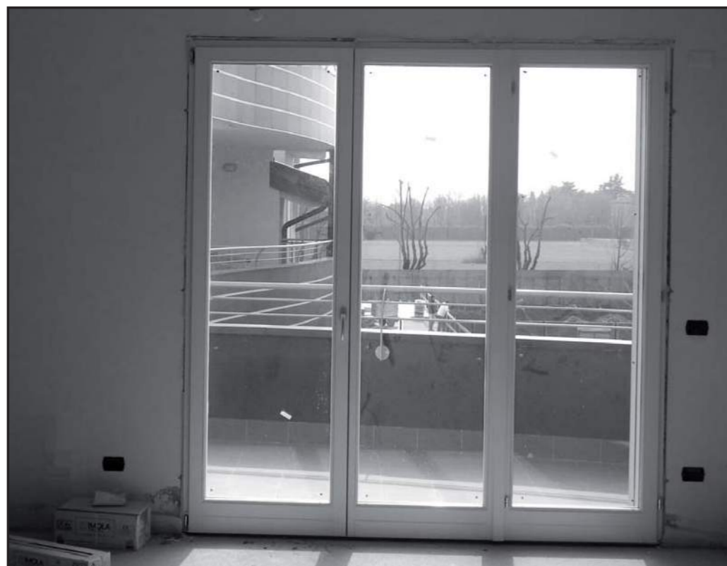
Fig. 3 – facciata collaudata vista dall'interno
