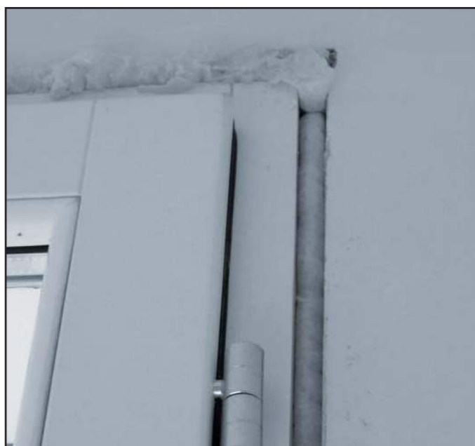
Figura 5 – sigillatura delle fughe
