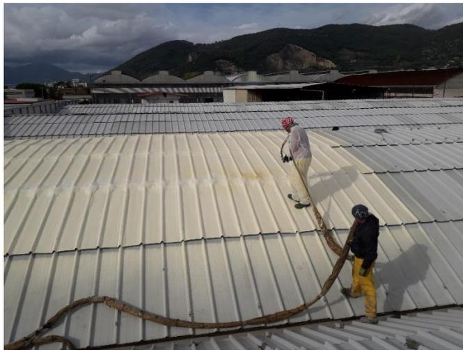
L'indice SRI descrive la capacità di una superficie irradiata dal sole di non scaldarsi. Si esprime con un numero %, che può essere anche superiore a 100 per il sovrapporsi dei due effetti di alta riflessione solare e alta emissività.
