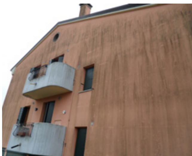
Attacchi di muffe e alghe su edifici isolati con sistemi a cappotto
