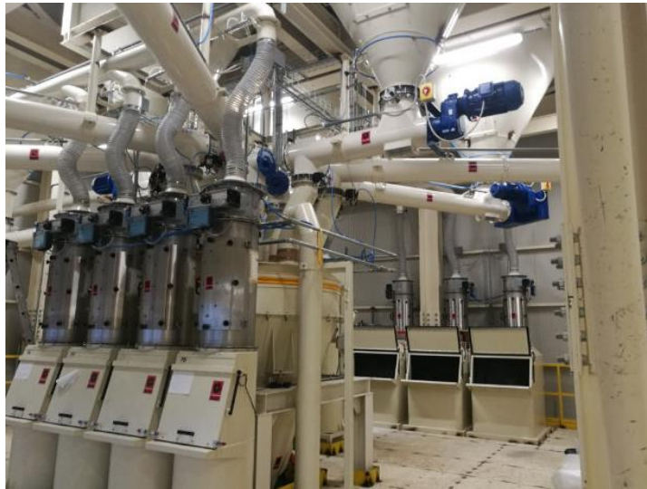
Stabilimento Xella Italia S.r.l. Pontenure (PC) Produzione malte
