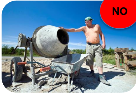
Tradizionale realizzato in cantiere
