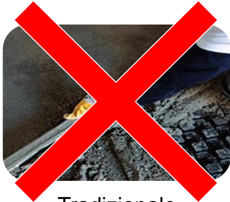
Tradizionale confezionato in cantiere
