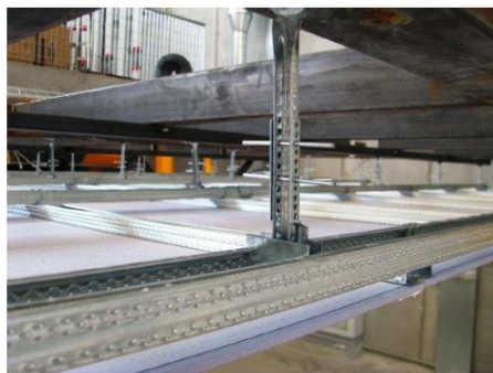
Allestimento di prova e rivestimento delle orditure in lastre di gesso.
