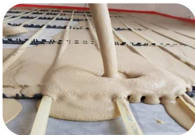
Autolivellante Anidritico
