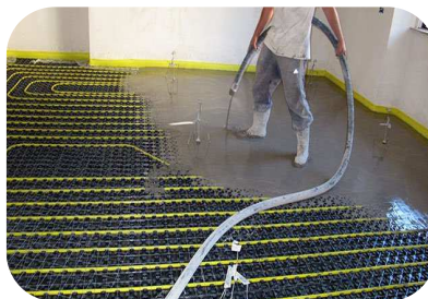
Autolivellante Cementizio
