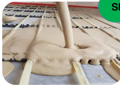
Autolivellante Anidritico
