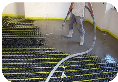
Autolivellante Cementizio
