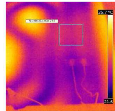
Ore 15:15 - Massetto tradizionale Temperatura media area = 23,6°C
