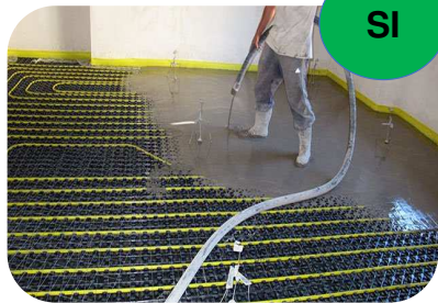
Autolivellante Cementizio
