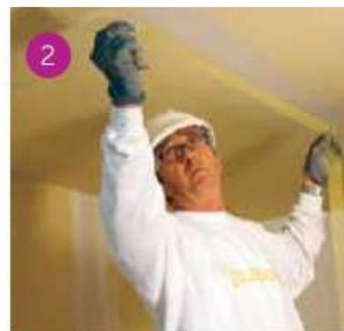
2 Applicare la banda in rete PregyAquaBoard centrandola sull'asse del giunto.
