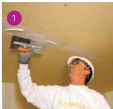
1 Riempimento del giunto con Stucco PregyAquaBoard e stuccatura della testa delle viti.
