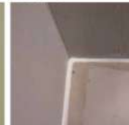
Sigilatura dei giunti perimetrali con massiccio sigillante acrilico verniciabile
