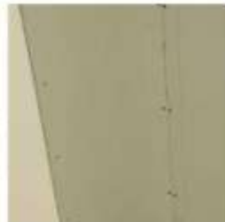
Avvitatura delle lastre solo sui montanti
