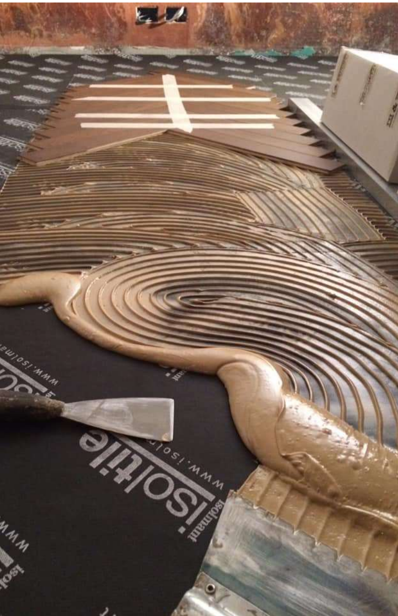
IsoTile BV (sd > 40) è specifico per le applicazioni con pavimento in parquet
