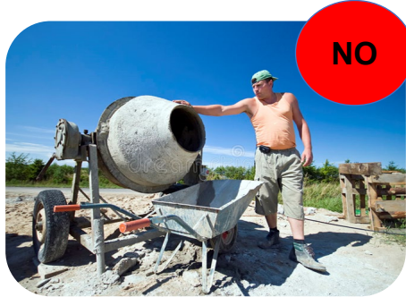
Tradizionale realizzato in cantiere
