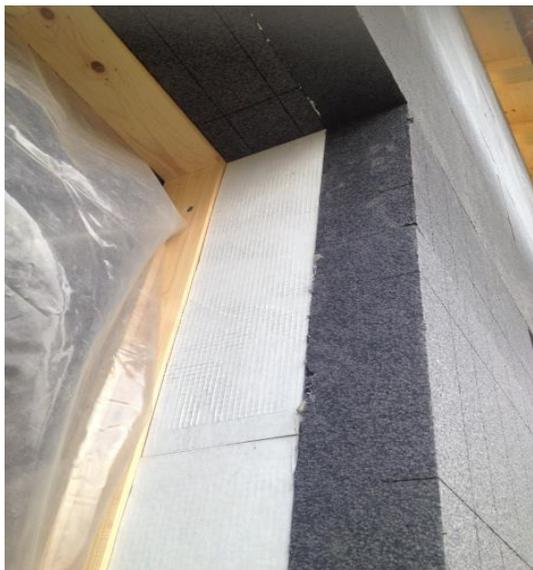
Importante isolare anche gli intradossi delle finestre per eliminare i ponti termici.
