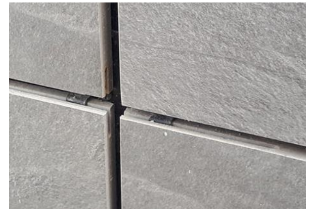
Fissaggio a scomparsa (fresatura kerf)
