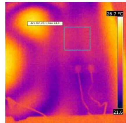
Ore 15:15 - Massetto tradizionale Temperatura media area = 23,6°C
