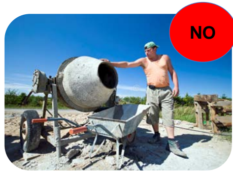
Tradizionale realizzato in cantiere
