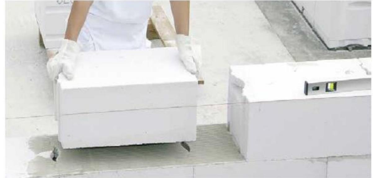
La malta collante Ytong FIX N200 è un premiscelato bianco ad alta resistenza ai solfati da usare per la posa a giunto sottile di murature in blocchi di calcestruzzo aerato autoclavato e incollaggio di elementi armati (architravi e pannelli). La malta collante non può essere usata come rasante.
