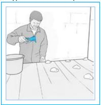
4. Eseguire il cordolo di adesivo continuo lungo i bordi della lastra ed applicare mucchietti di Knauf Perlfix di diametro pari a circa 10/12 cm sul retro della lastra
