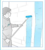
Per garantire un'ottimale presa del collante, il sottofondo va preventivamente trattato con un primer di tipo diverso a seconda che si tratti di un supporto assorbente o impermeabile.
