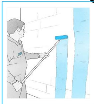
1. Per garantire un'ottimale presa del collante, il sottofondo va preventivamente trattato con un primer di tipo diverso a seconda che si tratti di un supporto assorbente o impermeabile.
