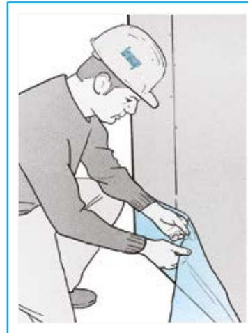
**5.** Applicare il nastro mono/biadesivo di guarnizione isolante in polietilene espanso sull'anima della guida, per contenere le trasmissioni acustiche laterali.
