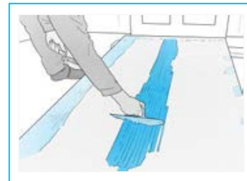
3. Per l'incollaggio di lastre di spessore 12,5 mm e Isolastre LM/PSE/XPS + 12,5 mm applicare un'ulteriore striscia adesiva longitudinale al centro.
