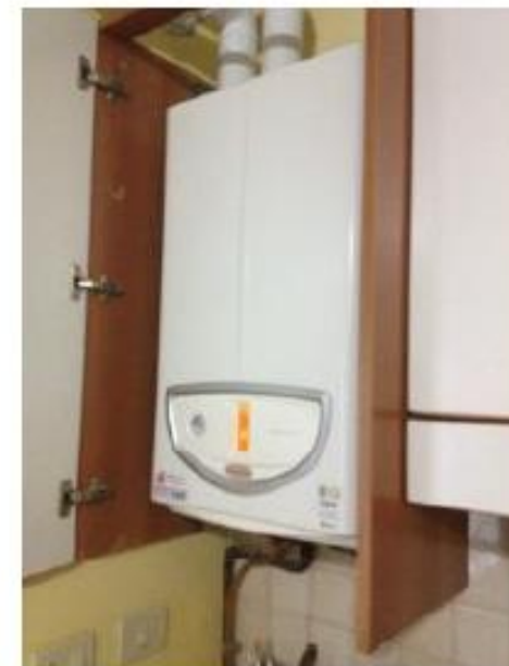
Caldaia di Tipo C
