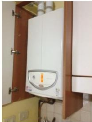
Caldaia di Tipo C
