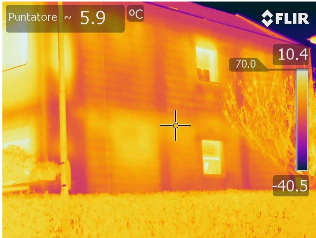
Tamponatura e struttura a telaio
