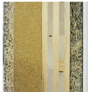
PARTIZIONI IN LEGNO Struttura in compensato di tavole
