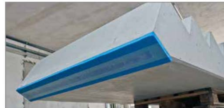
Abb. 67: Tronsole® Typ B fertig aufgeklebt
