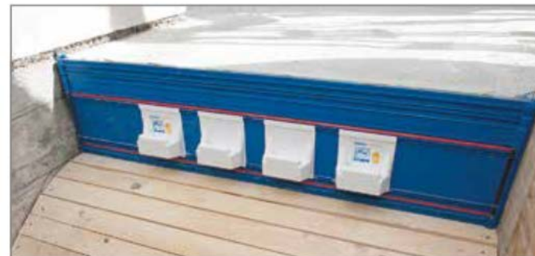
Abb. 34: Oberer Anschluss mit Tronsole® Typ I
