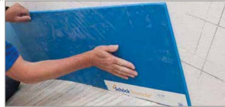
Abb. 74: Untere Hälfte von Tronsole® Typ L aufkleben
