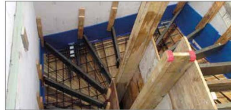
Abb. 75: Bewehrter Treppenlauf vor dem Betonieren
