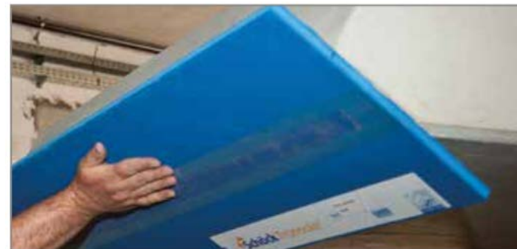
Abb. 65: Tronsole® Typ B an den Treppenfuß ankleben und andrücken, sodass das Elastomerlager Elodur® mittig im Treppenfuß liegt
