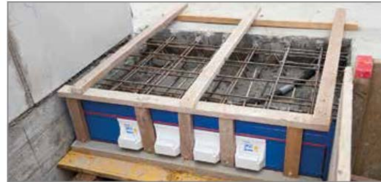
Abb. 32: Vor dem Betonieren
