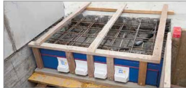
Abb. 32: Vor dem Betonieren
