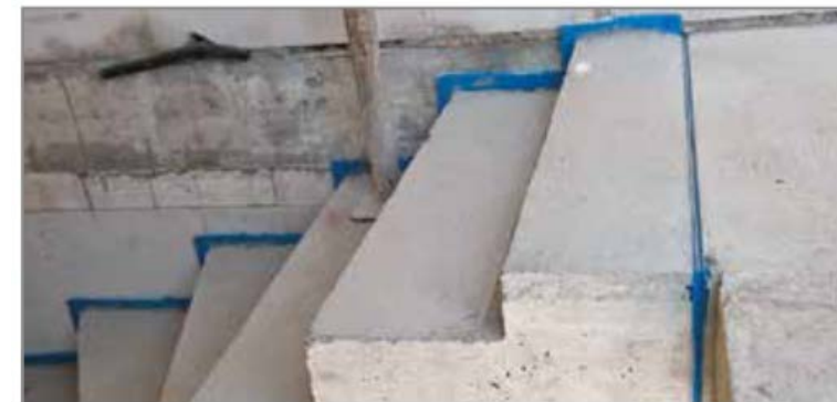
Abb. 79: Gerade Fugenausbildung am Treppenaustritt
