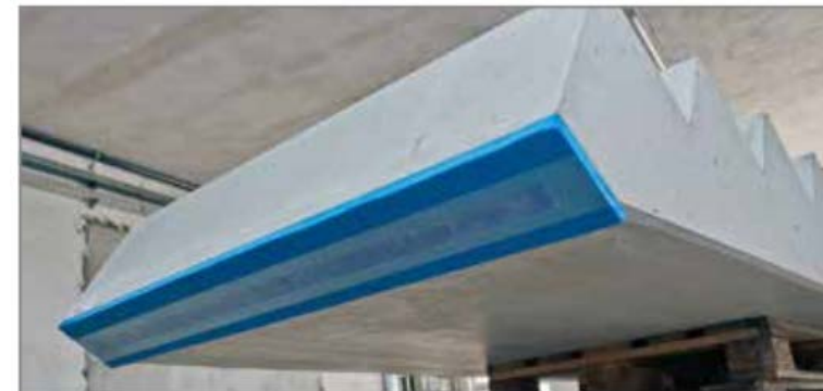
Abb. 67: Tronsole® Typ B fertig aufgeklebt
