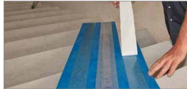
Abb. 64: Schutzfolie von Tronsole® Typ B abziehen
