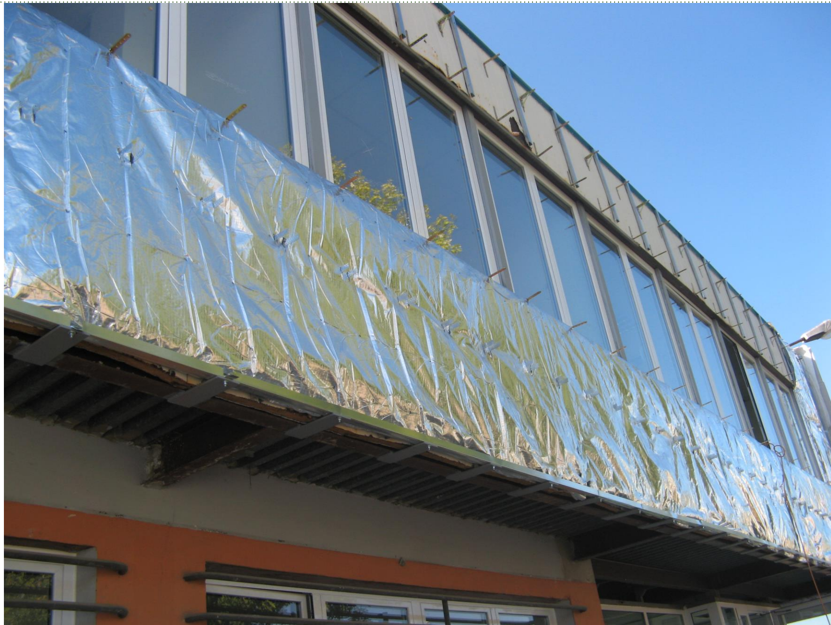
Cappotto palazzina uffici Modena
