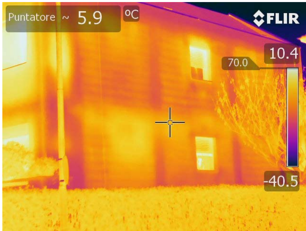
Tamponatura e struttura a telaio
