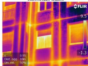
Sono ben visibili i giunti tra i pannelli prefabbricati
