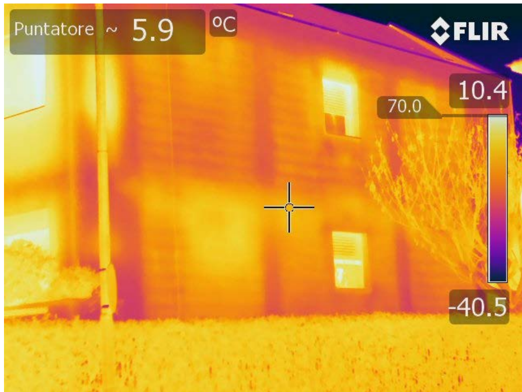
Tamponatura e struttura a telaio
