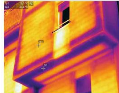
Facciata di edificio, \Delta T = 2.3 \text{ }^\circ\text{C} maggio, esposizione nord-ovest, pomeriggio
