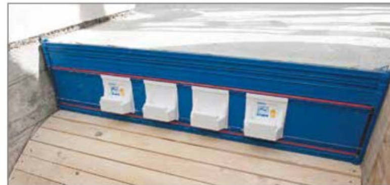
Abb. 34: Oberer Anschluss mit Tronsole® Typ I
