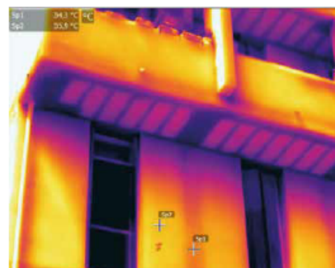
Facciata di edificio, \Delta T = 1.6 \text{ }^\circ\text{C} giugno, esposizione nord-est, pranzo
