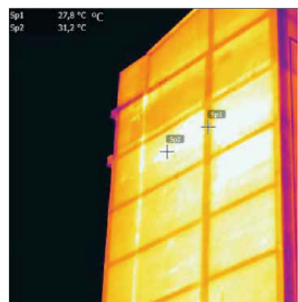
Facciata di edificio, \Delta T = 3.4 \text{ }^\circ\text{C} marzo, esposizione sud-ovest, pomeriggio
