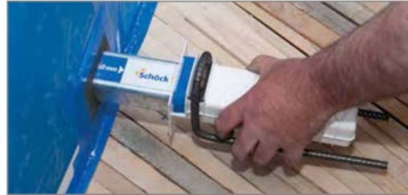
Abb. 52: Laufhülse aufstecken
