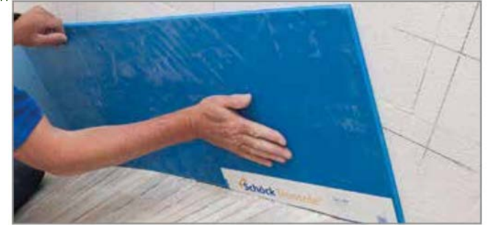
Abb. 74: Untere Hälfte von Tronsole® Typ L aufkleben
