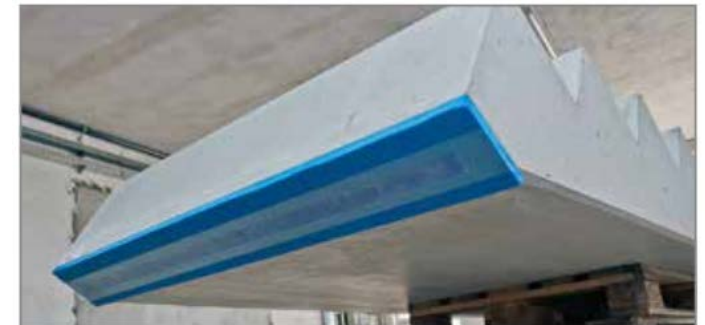
Abb. 67: Tronsole® Typ B fertig aufgeklebt
