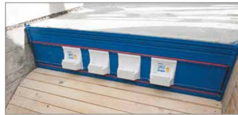
Abb. 34: Oberer Anschluss mit Tronsole® Typ I
