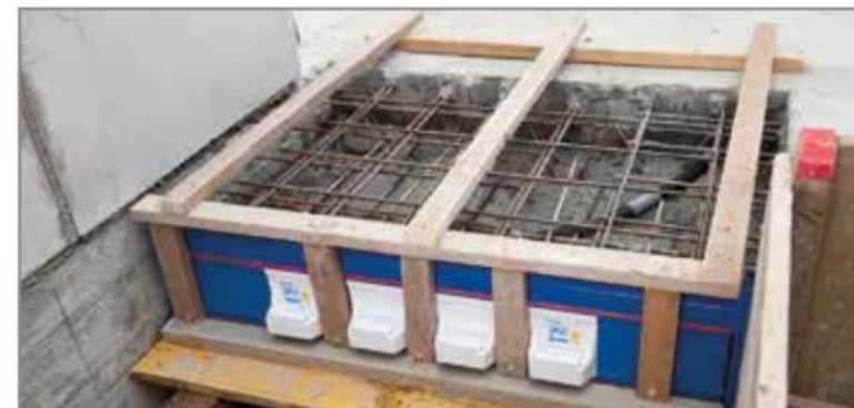
Abb. 32: Vor dem Betonieren
