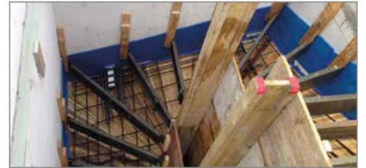
Abb. 75: Bewehrter Treppenlauf vor dem Betonieren
