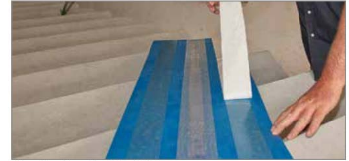
Abb. 64: Schutzfolie von Tronsole® Typ B abziehen
