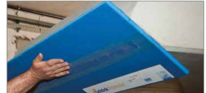
Abb. 65: Tronsole® Typ B an den Treppenfuß ankleben und andrücken, sodass das Elastomerlager Elodur® mittig im Treppenfuß liegt
