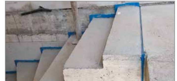
Abb. 79: Gerade Fugenausbildung am Treppenaustritt
