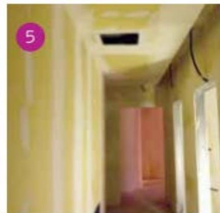
5 Lasciare asciugare per 24/48 ore in funzione delle condizioni atmosferiche e procedere con l'ultima mano di finitura per rendere planare il giunto.
