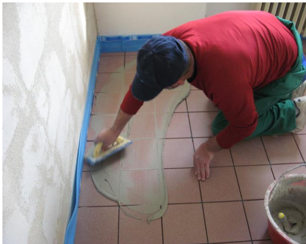
4 - Stuccatura con stucco Flessibilizzato
