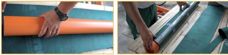
ISOLAMENTO ACUSTICO DI UNA TUBAZIONE DI SCARICO CON TOPSILENTAdhesive
