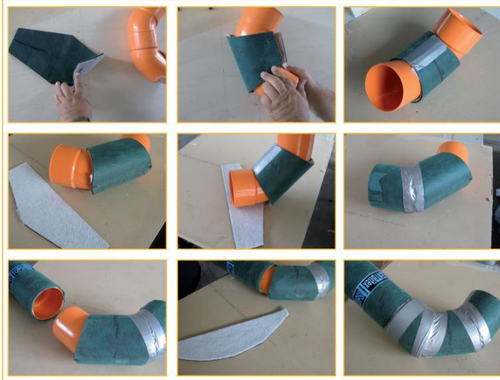
FASI PER L'ISOLAMENTO ACUSTICO DI UNA CURVA DI UNA TUBAZIONE DI SCARICO CON TOPSILENTDuo
