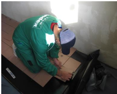
3- Dopo aver rullato... Rimozione 2° film siliconato e incollaggio piastrelle per adesione
