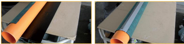
ISOLAMENTO ACUSTICO DI UNA TUBAZIONE DI SCARICO CON TOPSILENTAdhesive
