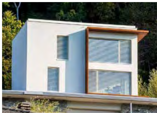
Foto 5 - Prospetto principale dell'edificio
