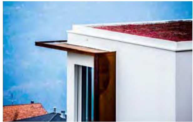
Foto 7 - Prospetto con dettaglio di copertura
