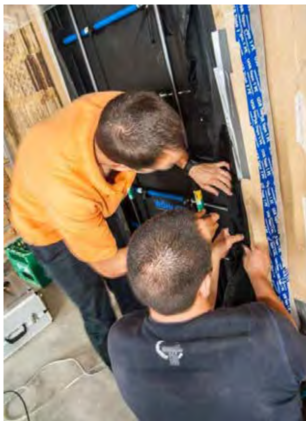
Foto 2 - Posa del telo per il Blower Door test preliminare
