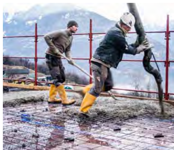
Foto 1 - Getto del calcestruzzo su solaio
