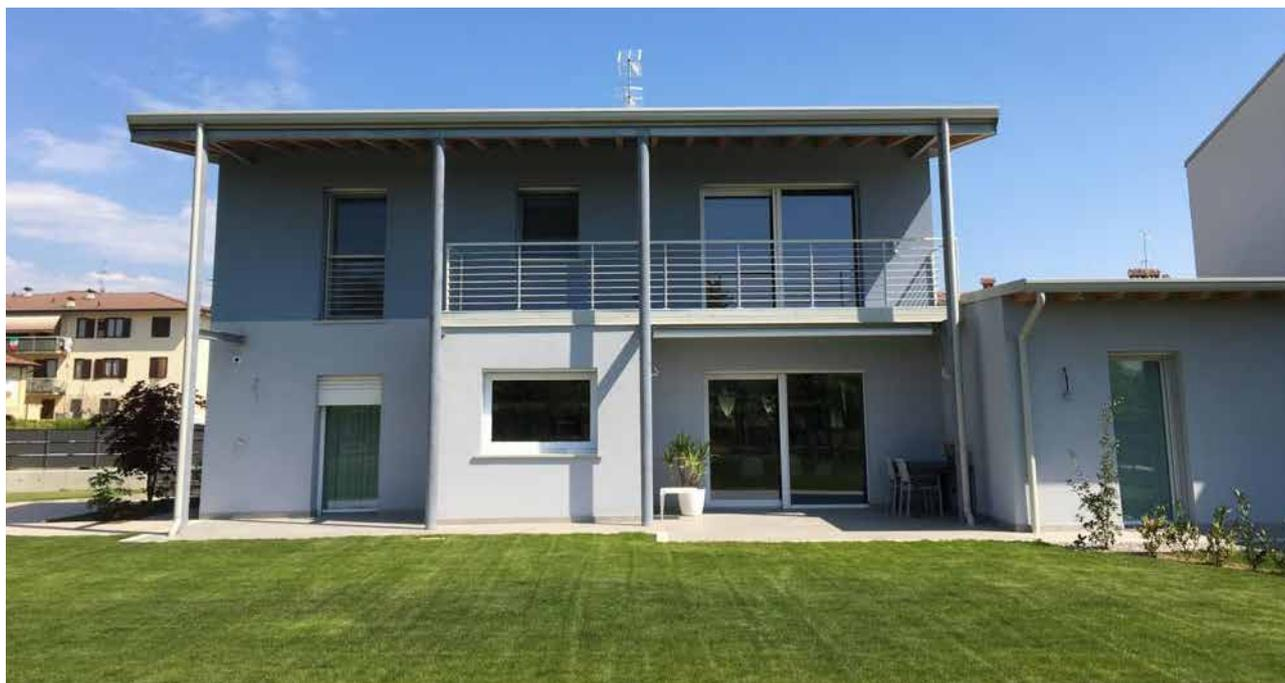
La casa è realizzata con tecnologia costruttiva di tipo “tradizionale” ovvero con pareti in laterizio portante, coibentazione esterna a cappotto dello spessore di 16cm (conducibilità 0.031 W/mK) e controparte isolante interna con spessore isolante 4 cm (conducibilità 0.035 W/mK). Il pavimento su terreno è isolato con 20cm di isolante ad alta densità e resistenza a compressione (conducibilità 0.035 W/mK).
