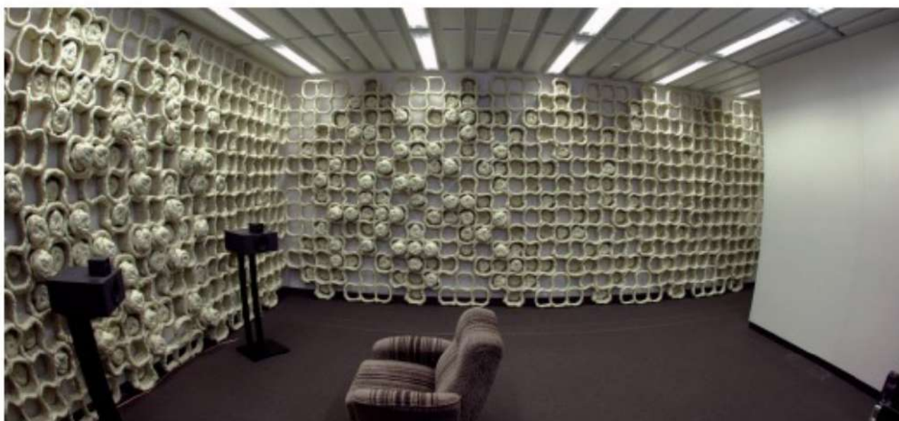
fig. 9 - Fabbricazione additiva di superfici fonodiffondenti in-situ e messa a punto dell'area d'ascolto (22).
