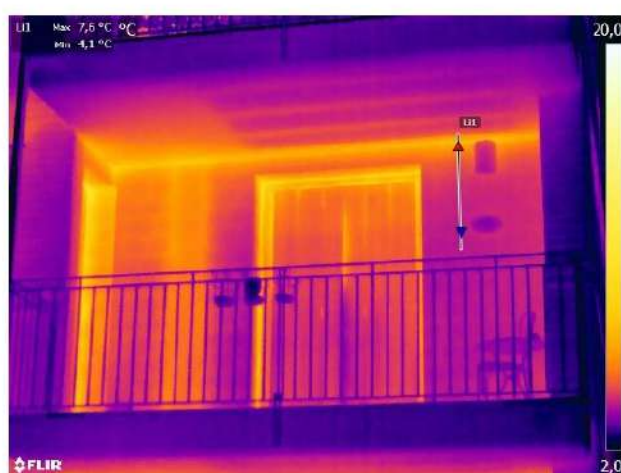
fig. 6 - Esempi di facciate con assenza di correzione dei ponti termici. La soletta in c.a. del balcone è direttamente a contatto con l'esterno ed è fonte di elevata dispersione termica
