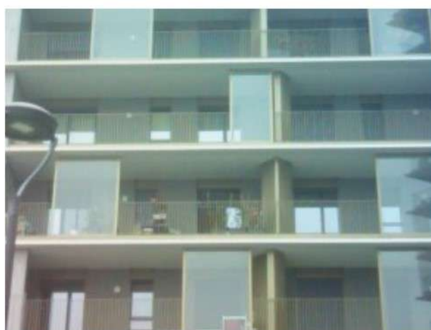
fig. 8 - Esempio di facciata con correzione dei ponti termici. La soletta in c.a. del balcone ha un elemento di taglio termico e quindi superficialmente la temperatura è omogenea ( \Delta T < 1 °C) come mostrato dai valori indicati dalla linea (massimo e minimo) - edificio realizzato a Milano - misure inverno 2022/23
