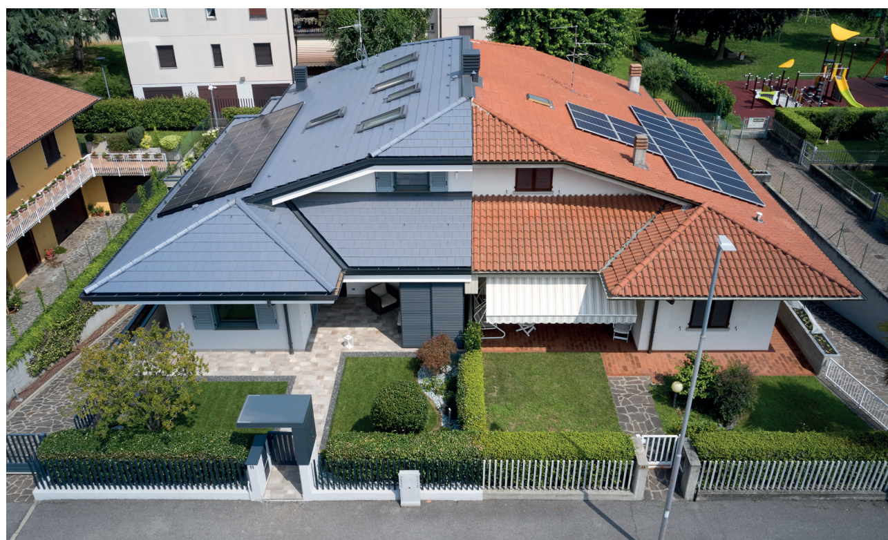
fig. 1: RenovActiv-ITA riqualificato nella metà di sinistra dell'edificio
