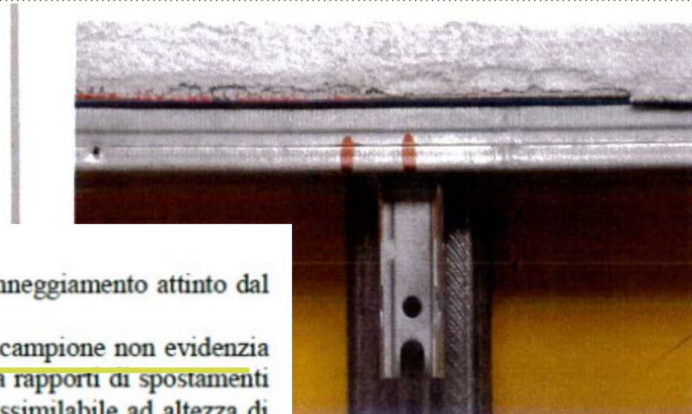
traverso alla base del campione rispetto al montante, evidenziato durante prove quasi statiche e dinamiche.
