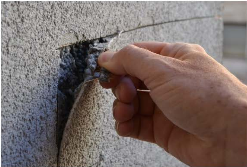
Esempio di valutazione dell'aggrappo dell'intonaco di fondo al pannello (punto 1)
