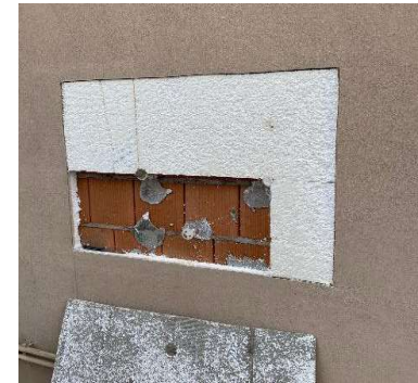
Verifica vecchio cappotto
