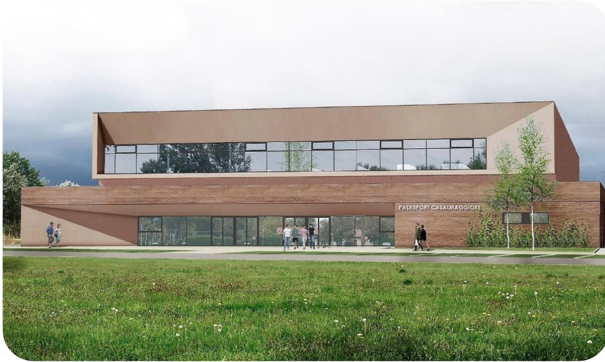
Palazzetto dello Sport Comune di Casalmaggiore (CR)
