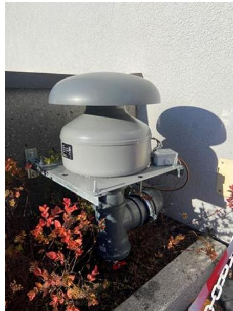
Le due immagini a sinistra mostrano un impianto pilota di drenaggio Radon, a destra un'immagine dell'impianto definitivo.
