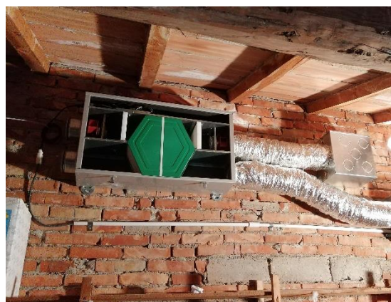
Foto di cantiere
