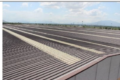
Immagine copertura capannone dall'alto
