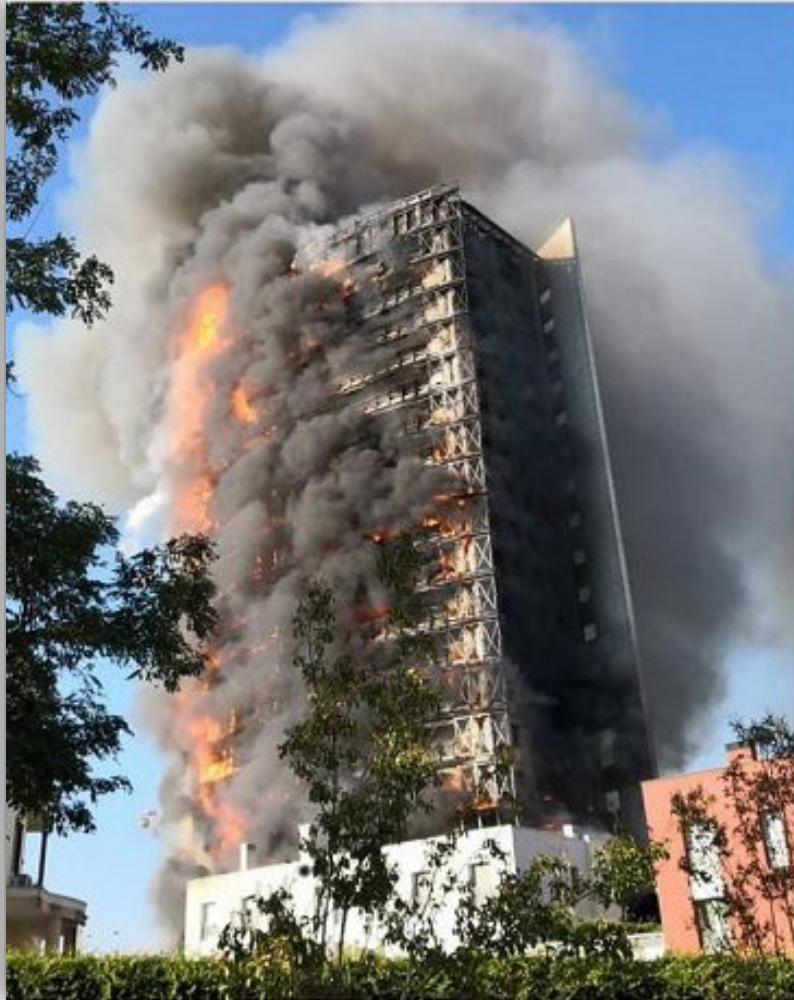
Incendio Torre del Moro - Milano 2021
