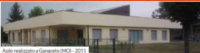
Asilo realizzato a Garaceto (MO) - 2011
