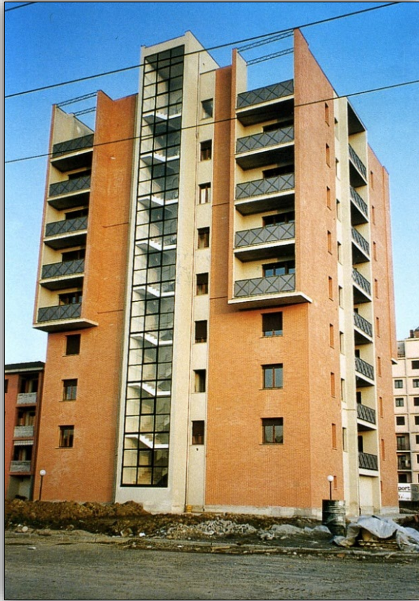
Applicazione di listelli Edificio 8 piani a Parma
