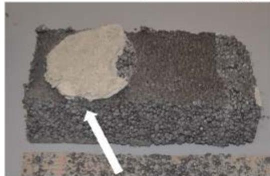
Incollaggio per punti nei pressi della zona del cordolo – retro del pannello
