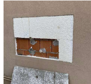
Verifica vecchio cappotto
