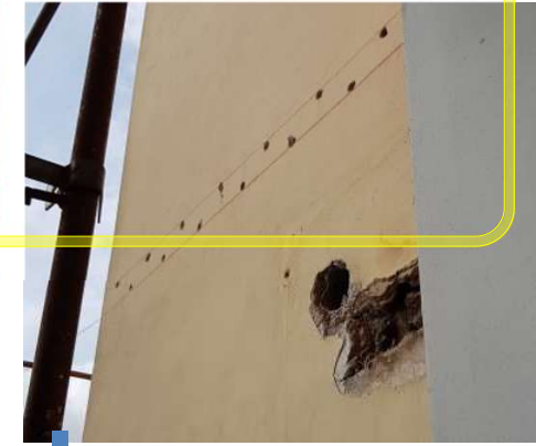
Preparazione dei fori e inghisaggio delle barre
