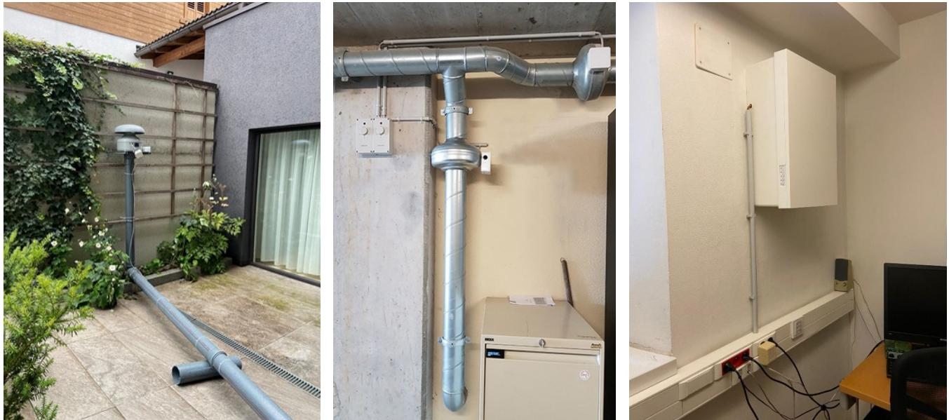
Esempi di risanamento radon (impianto pilota di drenaggio Radon, Sistema attivo, condotta e ventilatore esterni e VMC contro il radon).
