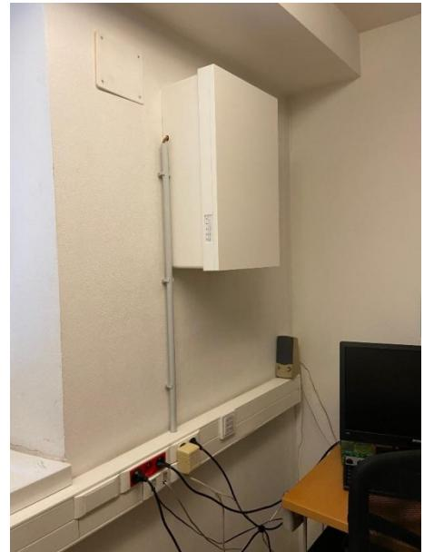
Esempi di risanamento radon (impianto pilota di drenaggio Radon, Sistema attivo, condotta e ventilatore esterni e VMC contro il radon).
